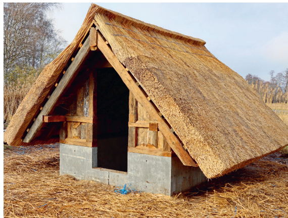
Die erste der insgesamt drei Slawenhütten ist fertiggestellt, das größere Rundhaus wurde danach errichtet.
