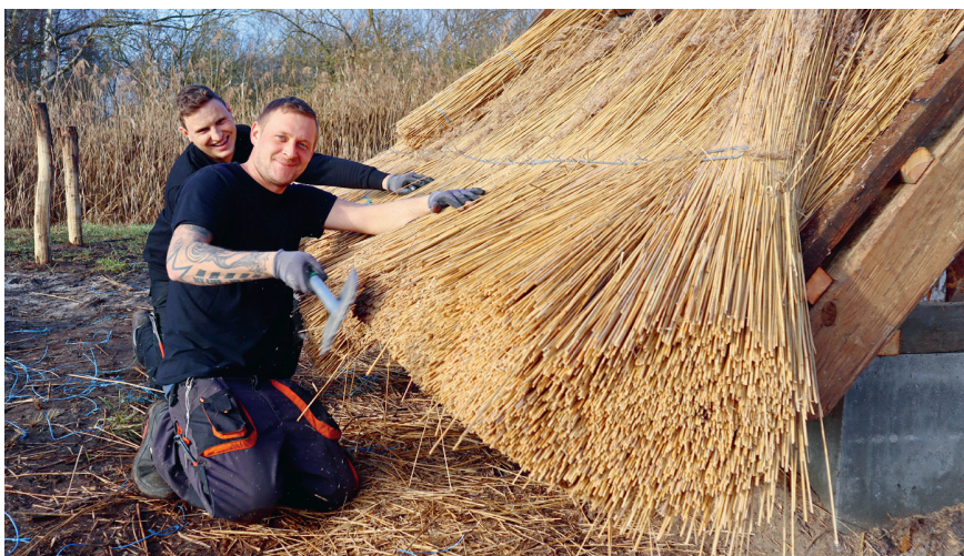
Mit dem sogenannten Klopfer verdichtet Christoph Rusch Lage für Lage des Reets auf dem Dachgestell, damit das Dach auch richtig dicht und undurchlässig wird. FOTOS: LAGA GMBH
